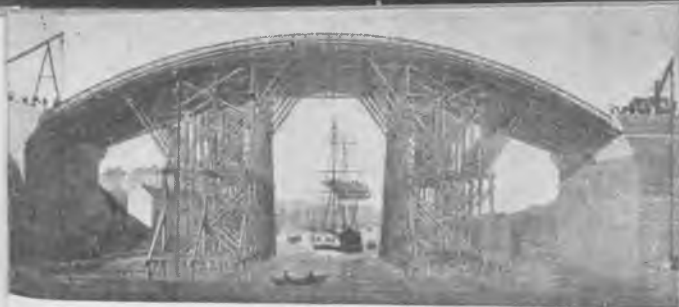
Jeden z pierwszych na świecie most żelazny na rzece Wear w porcie Sunderland w Anglii zbudowany w 1796 r.
