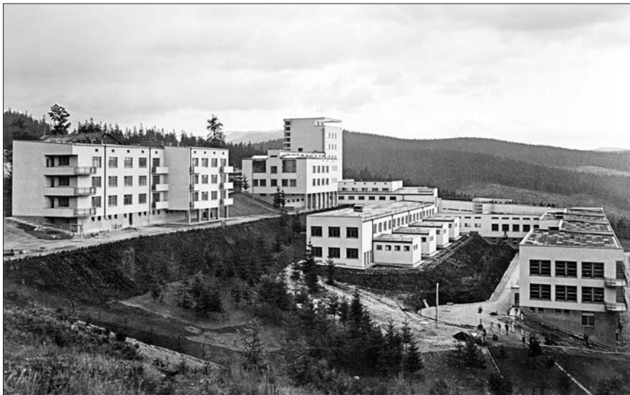
Sanatorium przeciwgruźlicze na Kubalonce zbudowane w latach 1931–1937 □ MŚC
