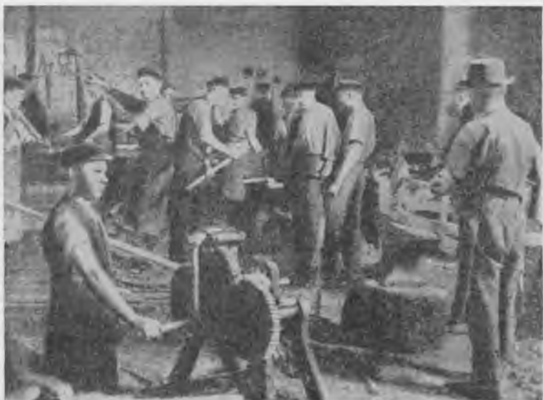
11. Kuźnia w fabryce kół i wozów H. Wagnera i S-ki, ul. Łucka 11 — fot. ok. 1910 r.
