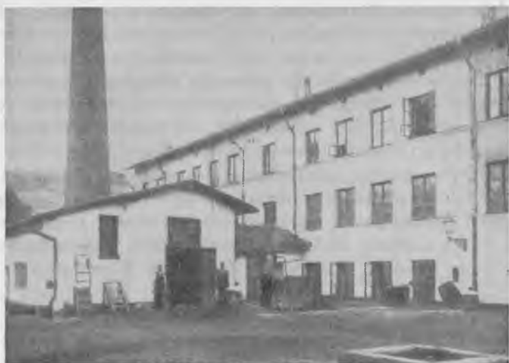
32. Budynek fabryki mydła toaletowego R. Wildta, ul. Belwederska 18 — fot. ok. 1900 r.
