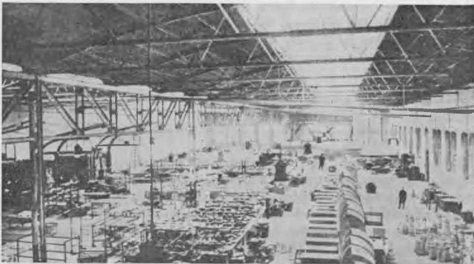
8. Wnętrze hali fabrycznej Warszawskiego Tow. Fabryk Wyrobów Metalowych i Emaliowanych, ul. Namiestnikowska 4 — fot. ok. 1914 r.
