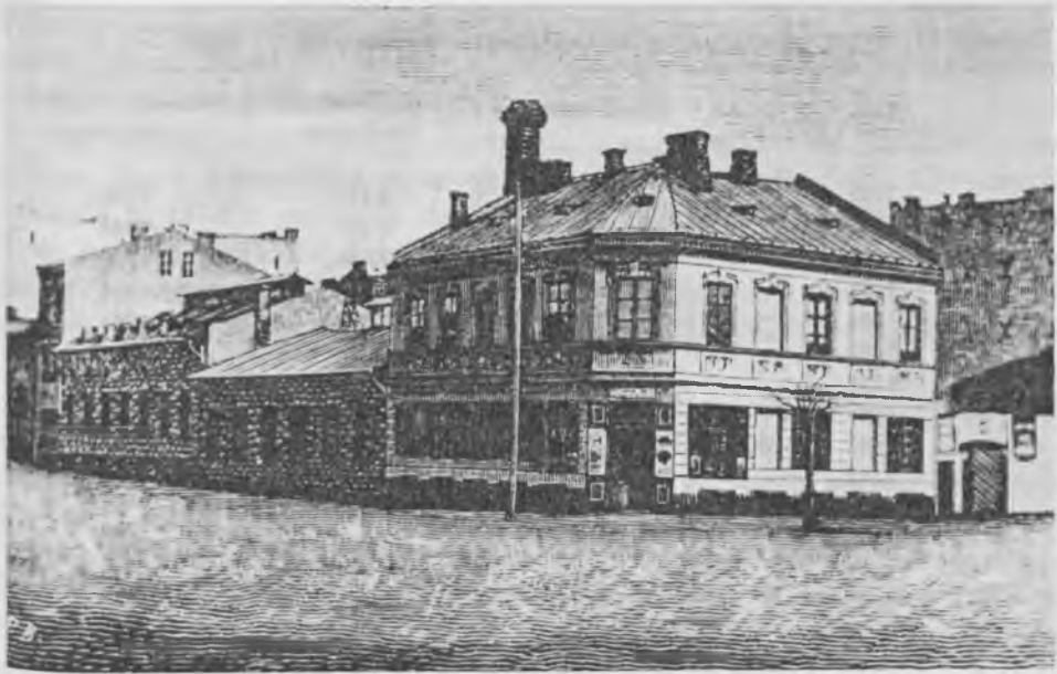
4. Dom i fabryka wyrobów metalowych A. Patzera ul. Ogrodowa 9 — rys. ok. 1895 r.
