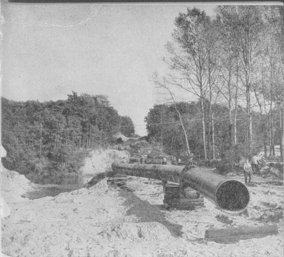
72. Widok z budowy rurociągu płockiego
