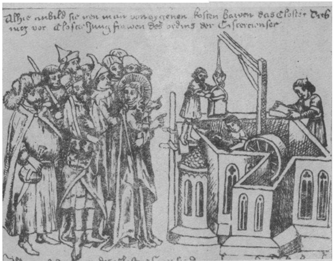
RYC. 13. BUDOWA KOŚCIOŁA W TRZEBNICY
